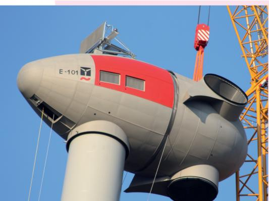
Seit Herbst 2013 erzeugen 7 Windkraftanlagen, vom Typ E101, den Großteil des Stroms im Bioenergiepark. Ein Turm besteht aus 28 Betonringen und 3 Stahlsegmenten. Mit einer Nabenhöhe von 149 Metern und einer Gesamthöhe von fast 200 Metern gehören die Windräder derzeit zu den höchsten Anlagen dieser Leistungs-kategorie. Der Vorteil in der enormen Höhe besteht darin, dass die Windgeschwindigkeit mit zunehmendem Abstand vom Boden steigt und dadurch eine größere Leistung aufgenommen werden kann.
